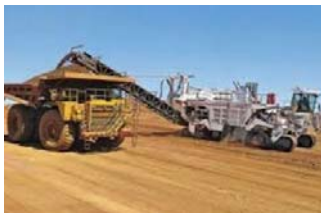
Wirtgen 4200 Direct Loading
